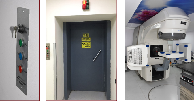
Şekil 2. Linac cihazı kapı ve çarpışma kilitleri
